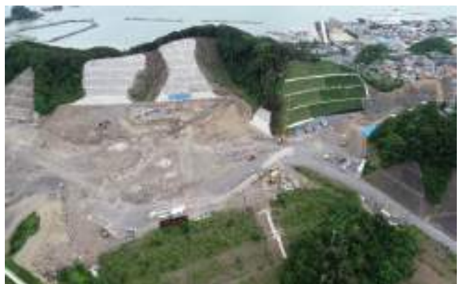
串本新庁舎造成工事
