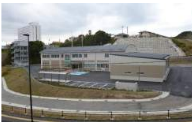
串本町消防防災センター建築工事
